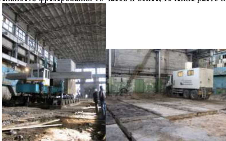
Подготовка к закладке фундамента станка SNK в блоке цехов
