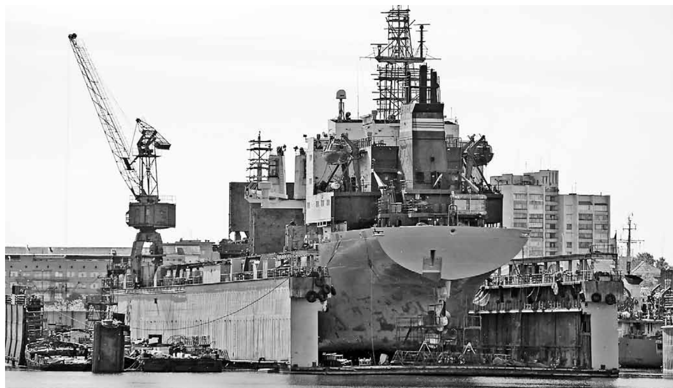
► В плавучем доке М-32 идет ремонт теплохода «Инженер Трубин»
