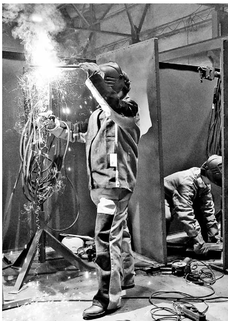
➤ Ручная электродуговая сварка в потолочном положении
